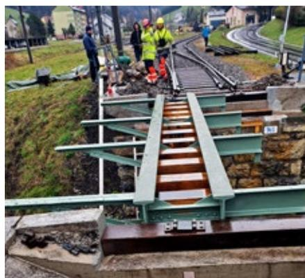
Zusammengebaute Brückenteile wurden in die Widerlager gehoben
